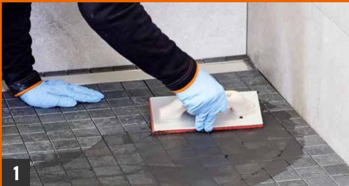
**Schritt 1:** Sehr leichtes Verfugen ohne Restschleier mit PCI Durapox Premium. Die Verarbeitung erfolgt spielend leicht mit Standard-Werkzeug. Epoxidharz-Spezialwerkzeug ist nicht mehr nötig. Nach ca. 10 – 45 Minuten die eingefugte Fläche mit einem Schwammbrett anemulgieren und sauber abwaschen.
