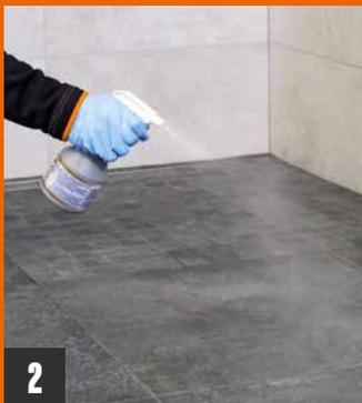
**Schritt 2:** Vor dem finalen Waschgang wird nach ca. 60 Minuten PCI Durapox Finish (flüssig) auf die Fläche aufgesprüht. Alternativ kann auch PCI Durapox Finish (Konzentrat) direkt in das Waschwasser hinzugegeben werden.
